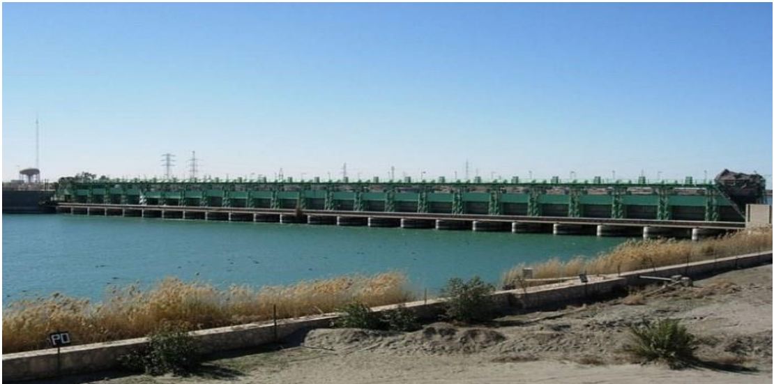
شكل رقم ( ٥ ) صورة من ارشيف مديرية طرق وجسور الانبار شكل سدة الجزيرة بعد الانشاء
