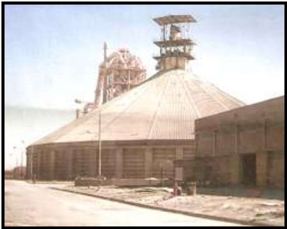
صورة-٥ مخزن الكلنكر المصدر: الدراسة الميدانية، ٢٠٠٨ .
