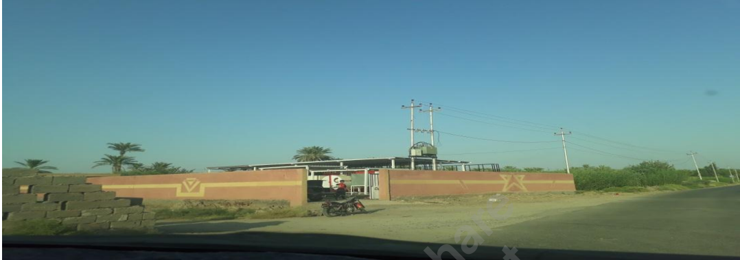
الصورة (١٠) احدى محطات الماء في منطقة الدراسة
