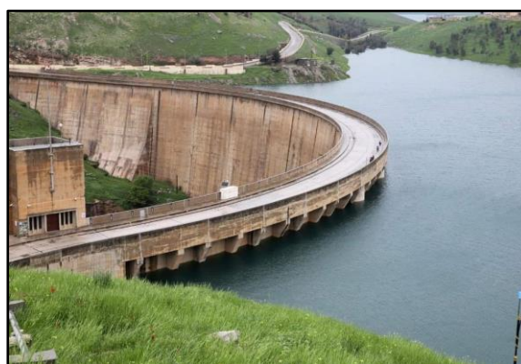
صورة (1) محطة سد دوكان
